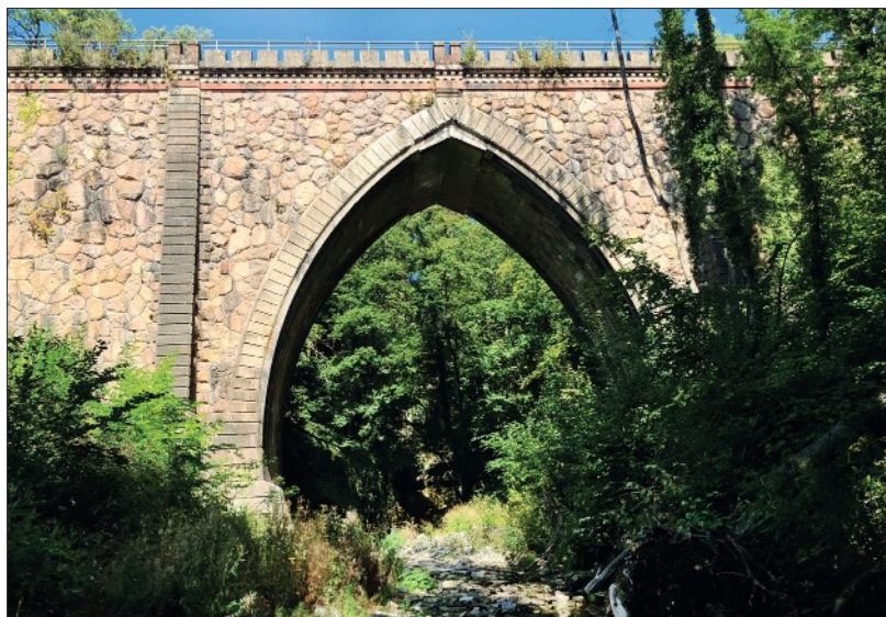
Die eingeschränkten Fotografiemöglichkeiten des Steina-Viaduktes nutzte am 16.9.2019 Claus Linke erfolgreich für die Aufnahme der seltenen Bauform einer Spitzbogenbrücke, Detailfoto rechts: der Schlussstein.
