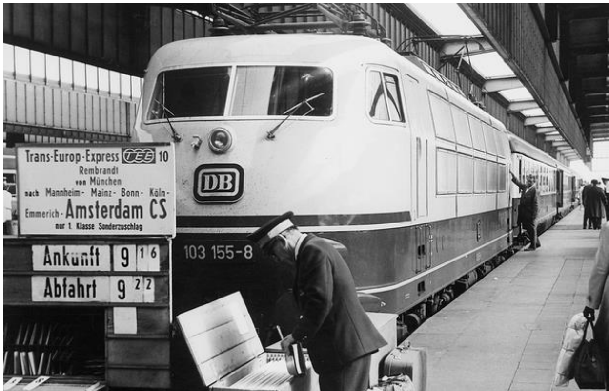
Mitarbeiter im Hauptbahnhof Stuttgart beim Auswechseln der Anzeigetafeln für den TEE "Rembrandt", 1972
